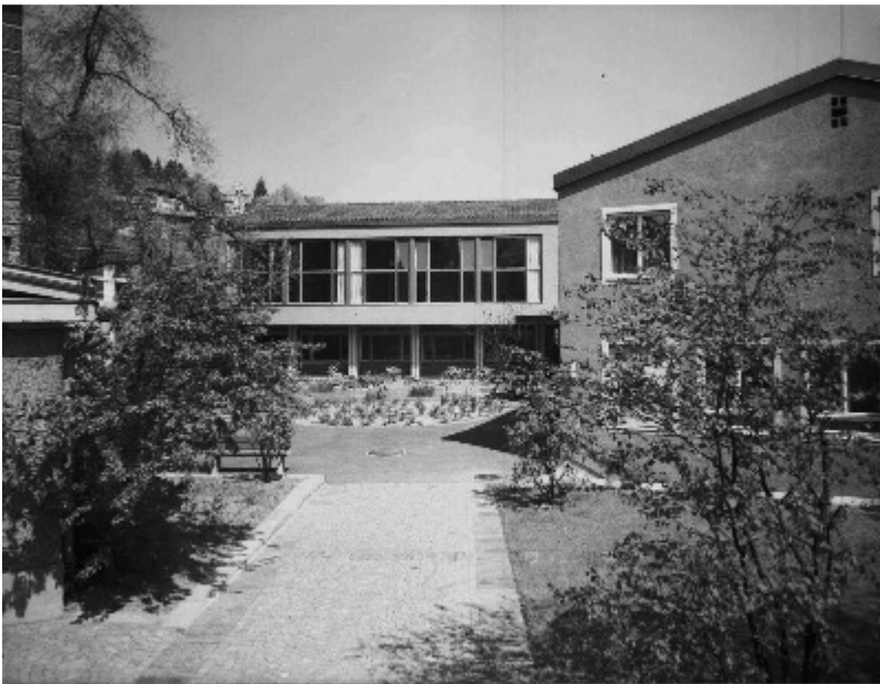
Kirchgemeindehaus St. Mangen 1960
