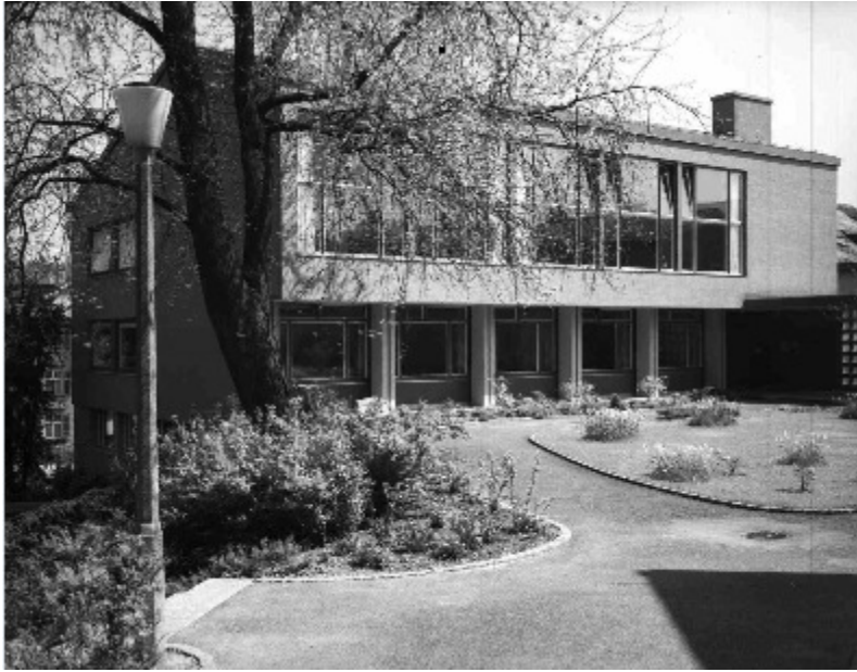
Kirchgemeindehaus St. Mangen 1960
