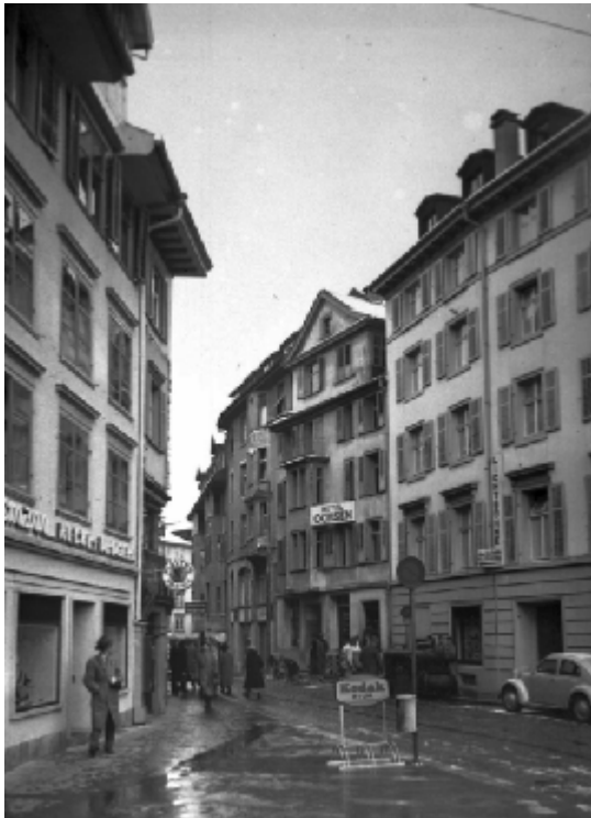
Hotel Ochsen vor Abbruch 1952
