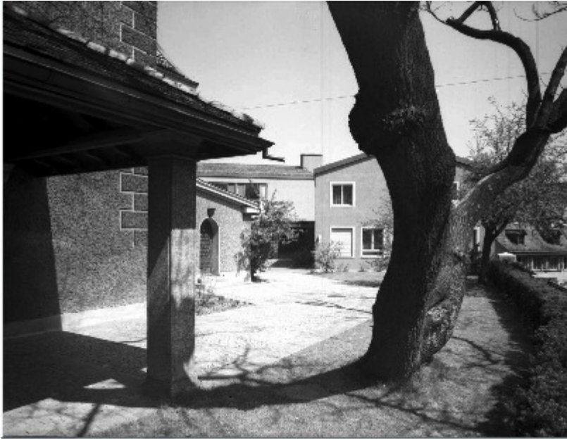
Kirchgemeindehaus St. Mangen 1960
