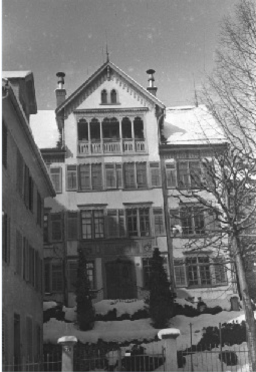
Haus zum Kirchbühl, Unterer Graben 27, 1900
